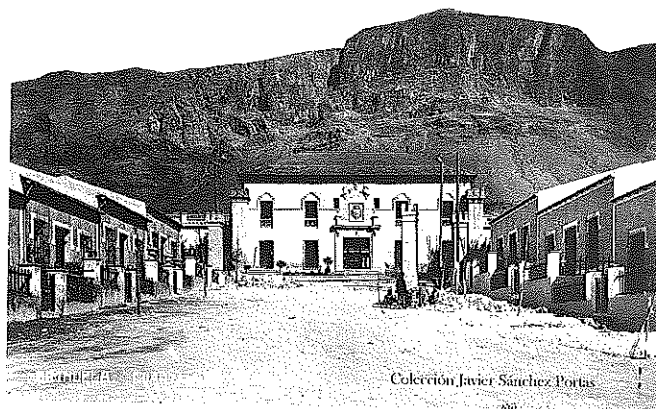
FIG. 4 Cuartel de Caballería
