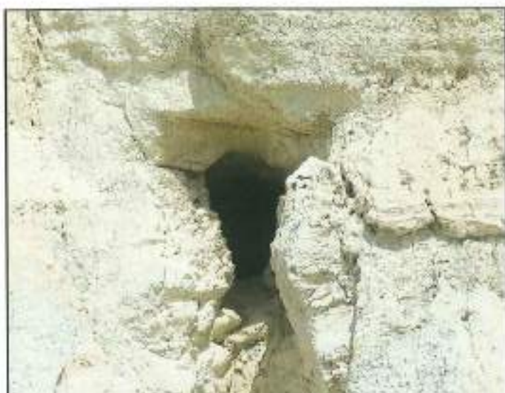
Figura 16.- Detalle del anterior aliviadero y respiradero.
