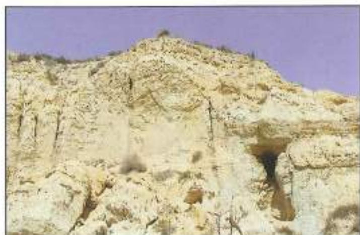
Figura 15.- Aliviadero y respiradero de la galería.
