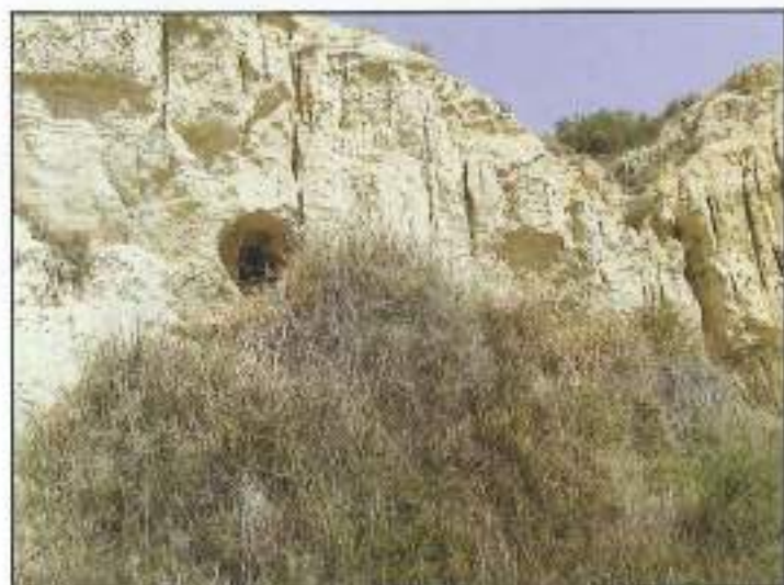
Figura 14.- Aliviadero y respiradero de la galería que sale hacia el ríombla.
