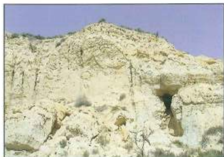
Figura 15.- Aliviadero y respiradero de la galería.
