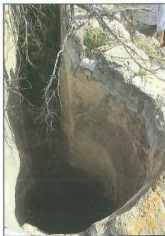
Figura 25.- Detalle del reservorio o cubo.
