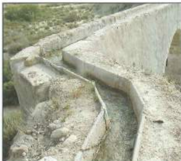
Figura 28.- Detalle de la canalización del acueducto.
