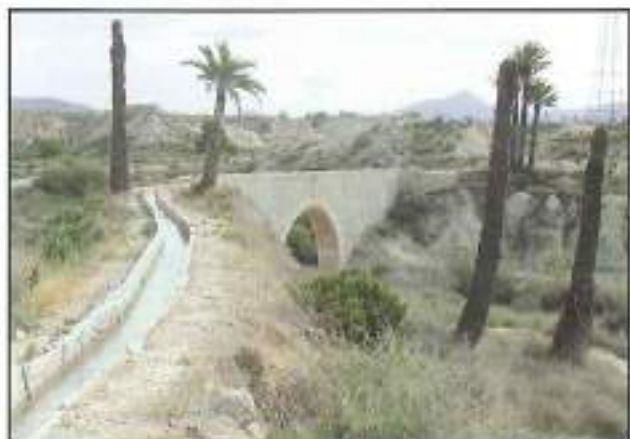
Figura 27.- Acequia que discurre hacia el Arco de Mª La Reina (acueducto).
