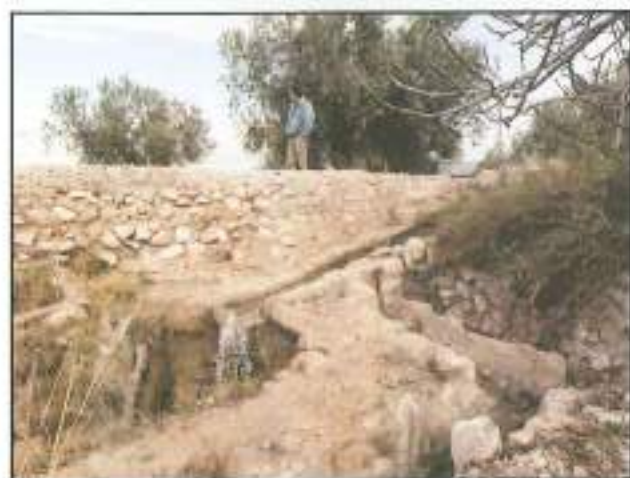
Figura 37.- Canales de distribución de agua salvando las pendientes y pedrizas de separación de bancales.
