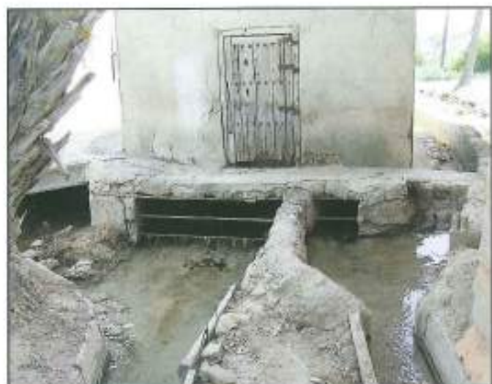
Figura 19.- Salida del Partidor donde se fracciona el caudal de agua y se dirige a las dos acequias de la huerta.
