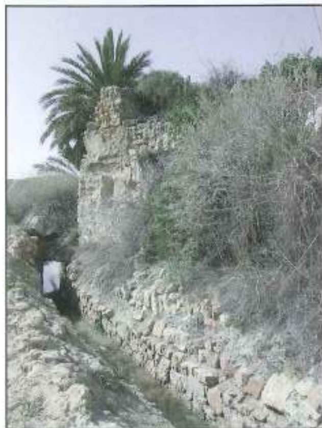
Figura 32.- Restos del antiguo Molino del Arco.
