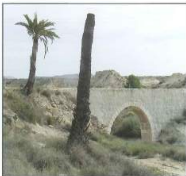
Figura 29.- Arco de la acequia.
