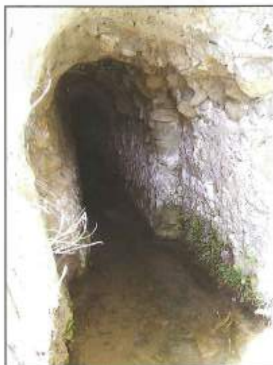
Figura 13.- Abertura recubierta del tramo de galería excavado en el monte de margas. Detalle del interior de la galería excavada.
