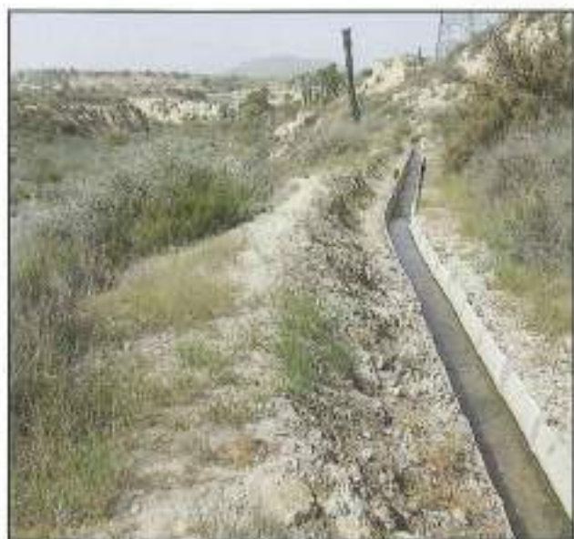
Figura 26.- Acequia a cielo abierto del sistema.
