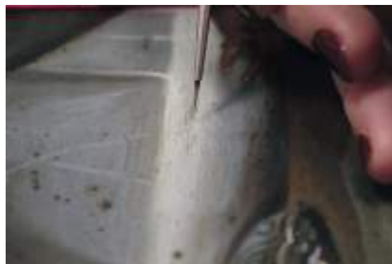
28. Detalle de reintegración de puntos de oxidación.
