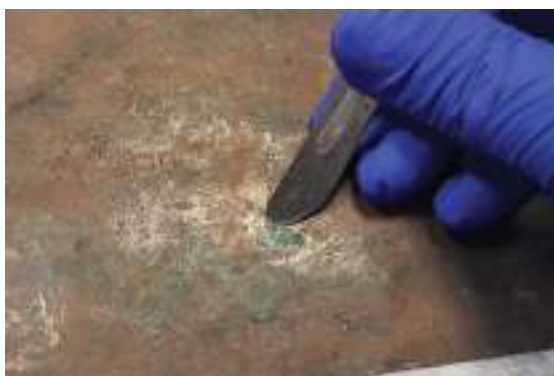
20. Detalle de limpieza de óxido verdoso.
