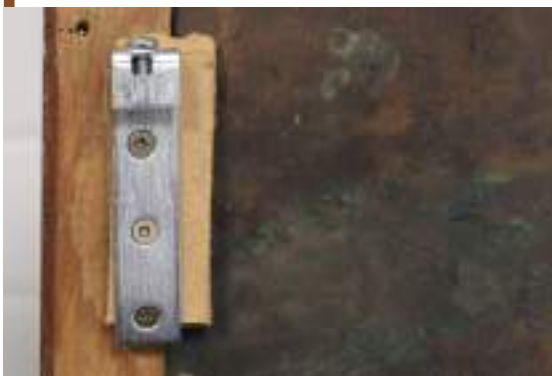
18. Detalle del sistema de colgado.
