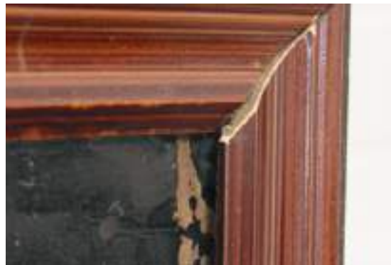
16. Marco inadecuado de una intervención anterior.
